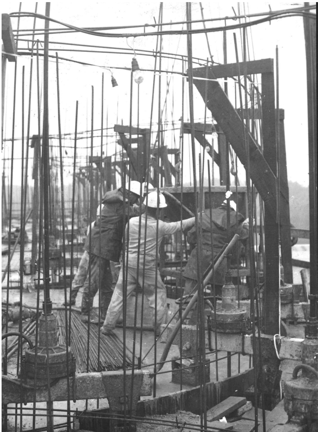
17. kép. A munkaszint közeli képe. A munkaszint a felfelé mozgó zsaluzatra van építve.
