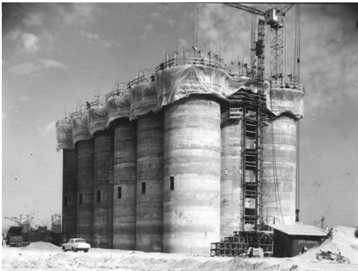
20. kép. Mezőkovácsháza 2230 vagonos siló. Az friss betont az időjárás hatásaitól védeni kell.
