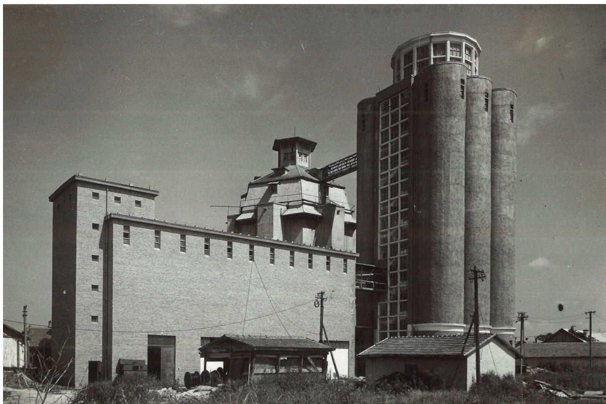
4. kép. Nagytétény hizlalda 300 vagonos siló, Payr Egon 1954-55. monolit íves falzsaluval MIEA mező 2035/413, IÉSZ17 A korábbi 1914-ben épült
